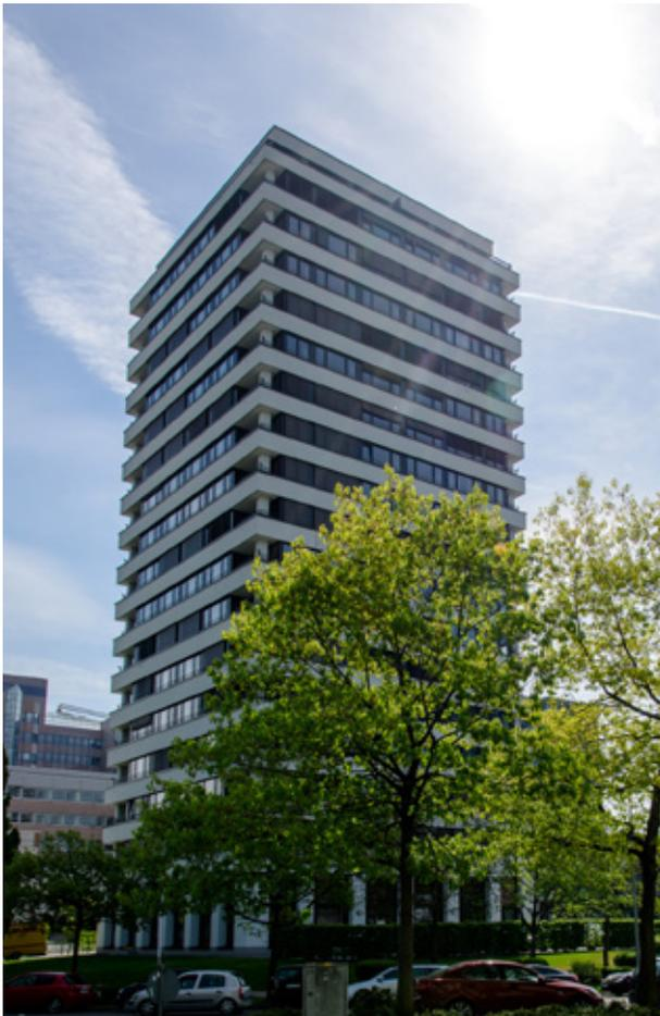
Das Gebäude wurde in konventioneller Massivbauweise errichtet und im Zuge des Umbaus 2010 mit einem zeitgemäßen Ausstattungsstandard versehen, u. a. wurde die Fassade dabei mit einem Wärmedämmverbundsystem ausgestattet.
